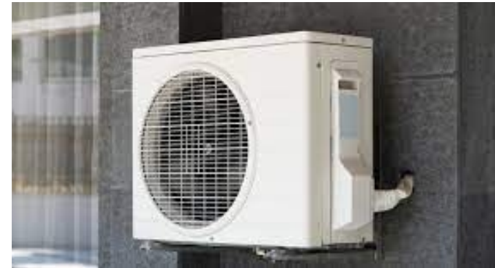
Pompe à chaleur
